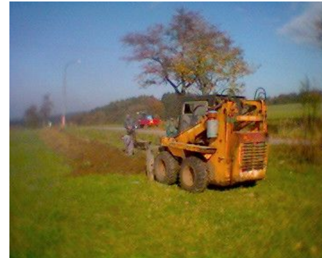
Pokládání nového kabelu.
